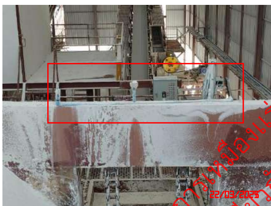
ระบบส่งน้ำบริเวณแก่งก้าเน็ดฝุ่นละออง
